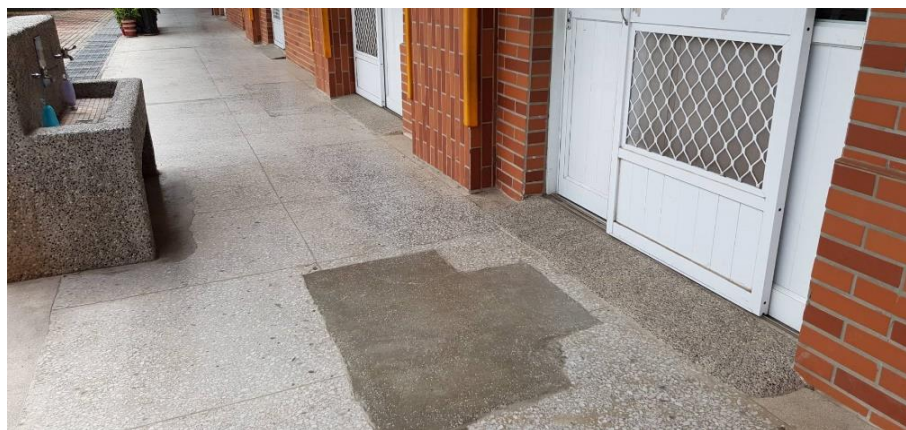
教室出入口斜坡
